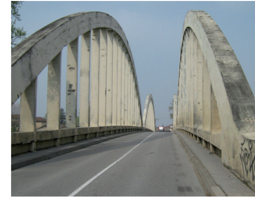
Le pont de Loyettes avant les travaux
