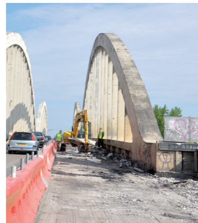
Le pont de Loyettes en travaux - Avril 2011
