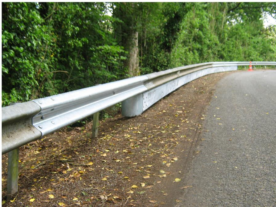
Les « lisses motos », tout comme les glissières de sécurité qui les supportent, sont des éléments de sécurité dite « passive » ou « secondaire » dont le rôle est de réduire les conséquences corporelles d'un accident de la circulation ; ceci par opposition aux éléments de sécurité dite « active » ou « primaire » dont le rôle est de réduire le nombre d'accidents de la circulation. Les « lisses motos » peuvent également être efficaces pour les cyclistes.
