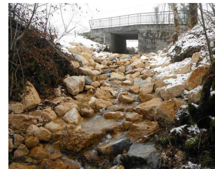
Avant les travaux
