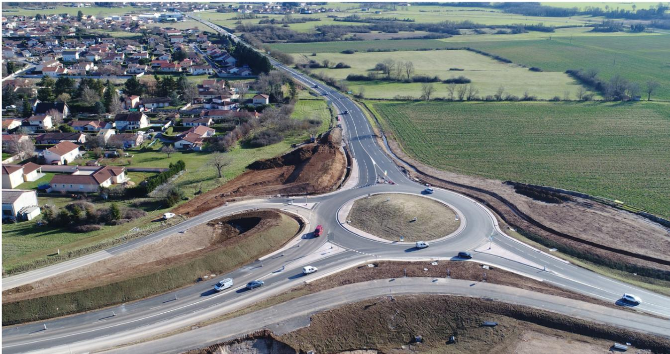
*"L'ancien carrefour, à multiples bretelles, n'était pas toujours facile à appréhender par les automobilistes. C'est pourquoi, nous avons décidé de le supprimer et de le remplacer par un giratoire plus simple, adapté aux flux de circulation. Ce nouvel aménagement vient sécuriser les déplacements des automobilistes et améliore, aussi, la desserte de Saint-Denis-en-Bugey".*
