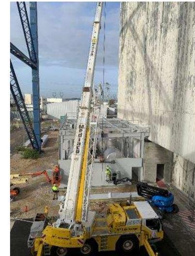
Mise en place des réservoirs d'entreposage des effluents et de la charpente métallique
