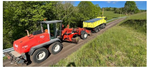
Mise en œuvre en régie de Grave Emulsion à la niveleuse
