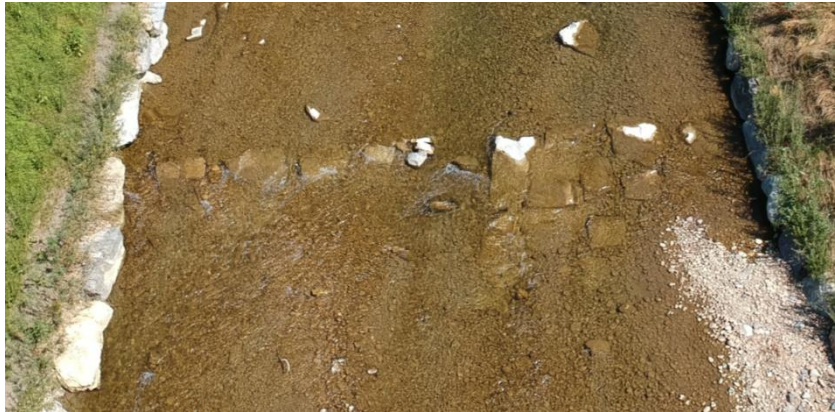
Exemple de pavage de fond
