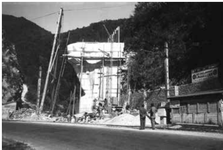
Photographie – Construction du Monument à la mémoire des maquis de l'Ain 17 juillet 1950 Fonds Robert Jaine
